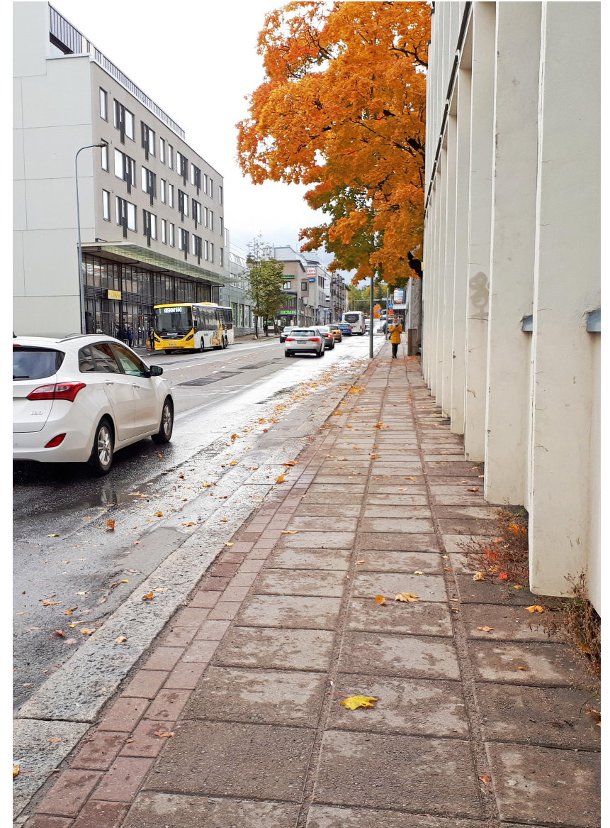
Jalkakäytävän betonikiveys, lokakuu 2019
